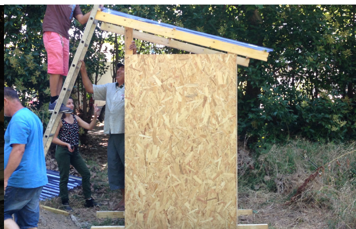
7. RÉALISATION DE TOILETTES SÈCHES
