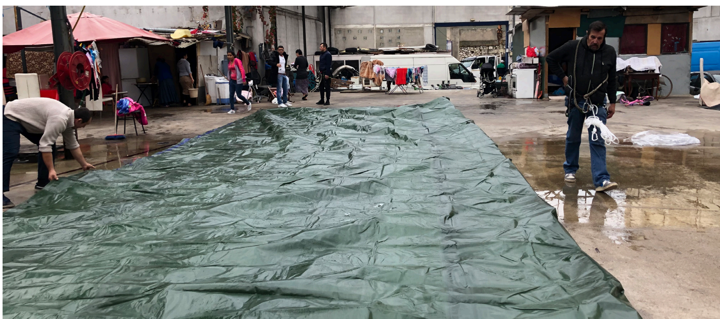
LE RACCORDEMENT DES BÂCHES ENTRE ELLES
