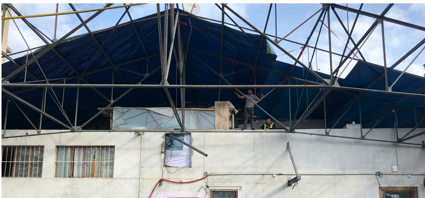
LES BÂCHES SUR LA STRUCTURE
