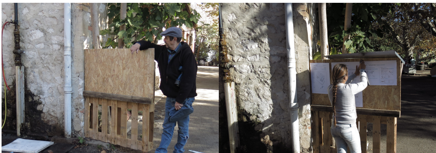
2. CRÉATION D'UN PANNEAU DE CHANTIER
