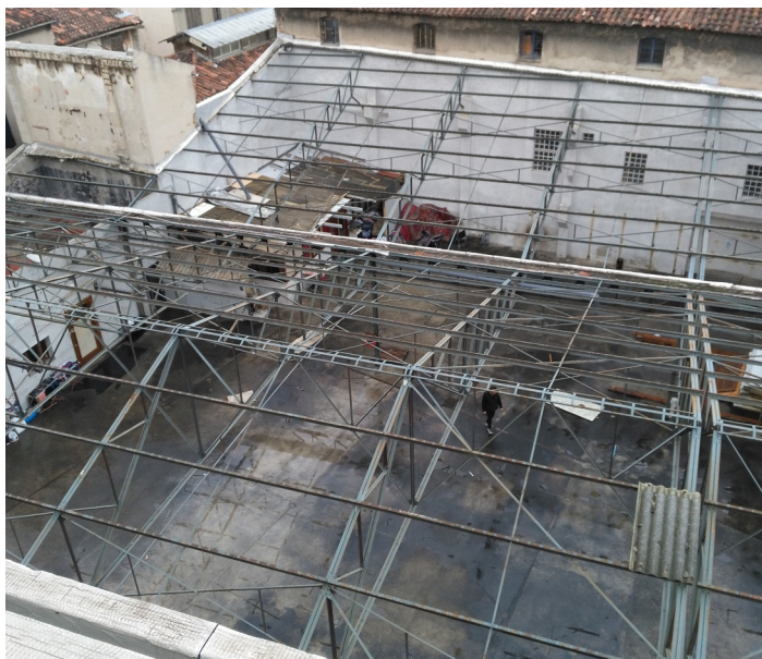
LA STRUCTURE AU DESSUS DE LA COUR CENTRALE
